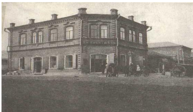
Рис. 4. Начало XX в. Дом купца Н.А. Климушкина. Вечерний филиал КИИ размещался в здании управления Куйбышевгидростроя в г. Ставрополе-на-Волге (строение до наших дней не сохранилось). Фотография из архива Тольяттинского краеведческого музея
