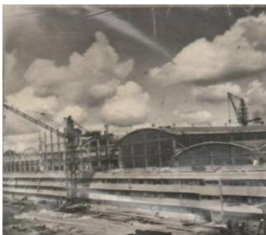
Рис. 2. Строительство Волжской ГЭС. Фотография из музея Тольяттинского государственного университета
