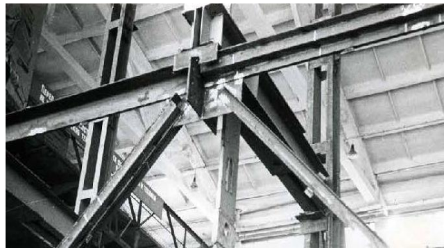
Рис. 3. Узел усиленной фермы
