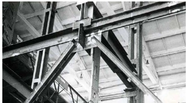
Рис. 3. Узел усиленной фермы
